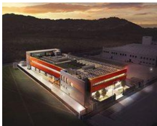
Figura 1 – Data Center IT1
