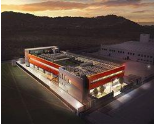
Figura 1 – Data Center IT1
